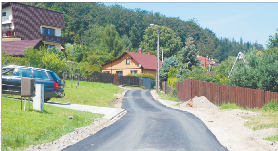
Warstwa asfaltu wykonana została m.in. na ulicy Pod Skocznią w Mesznej. W tym sołectwie prace w I etapie budowy kanalizacji są już na ukończeniu.
