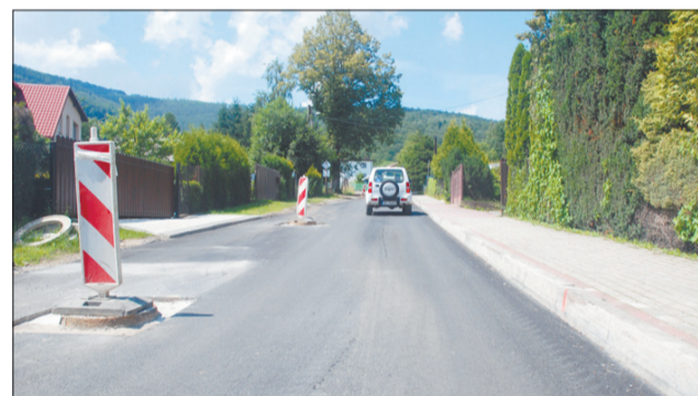
Ulica Orczykowa w Mesznej przygotowana pod drugą warstwę asfaltu.
